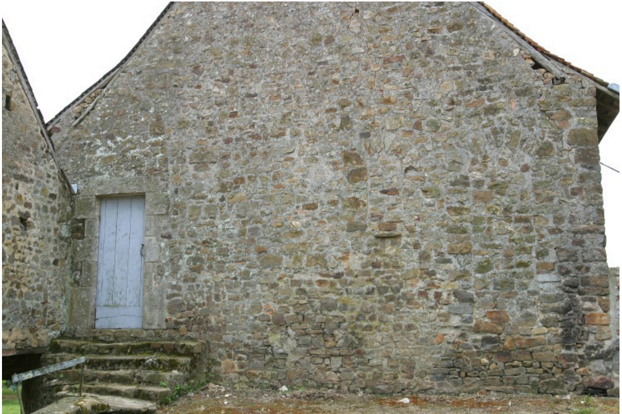
L'élévation nord du logis.
