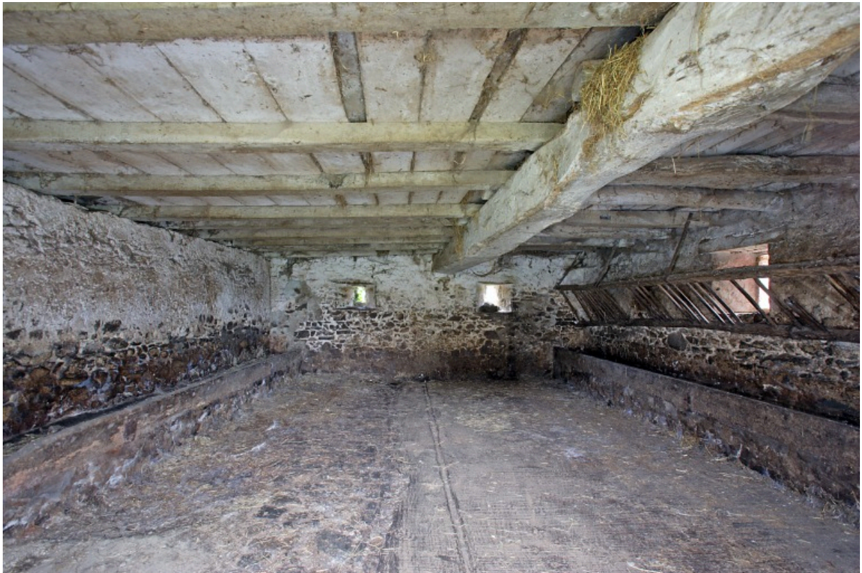
L'étable-grange, vue intérieure. L'étable sud vue depuis l'ouest.
