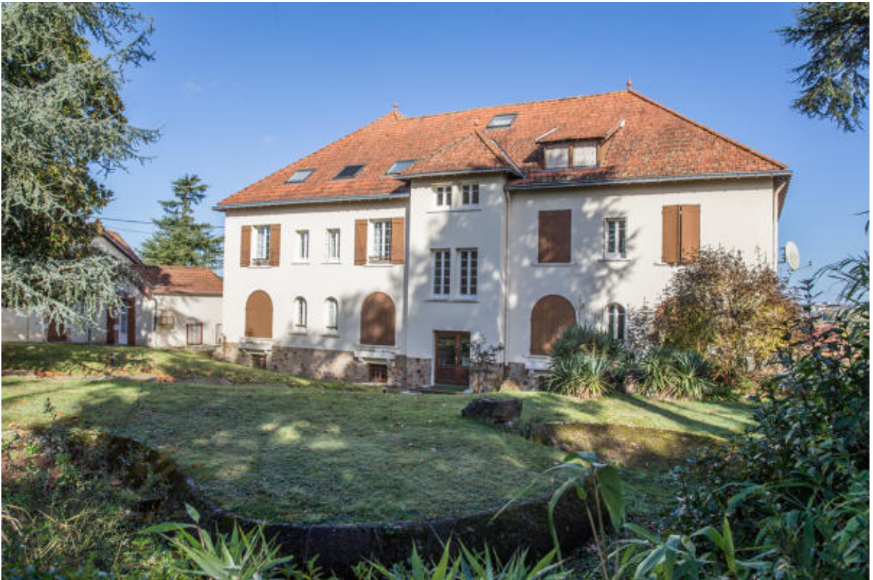
Immeuble à logements, impasse du Calvaire.
