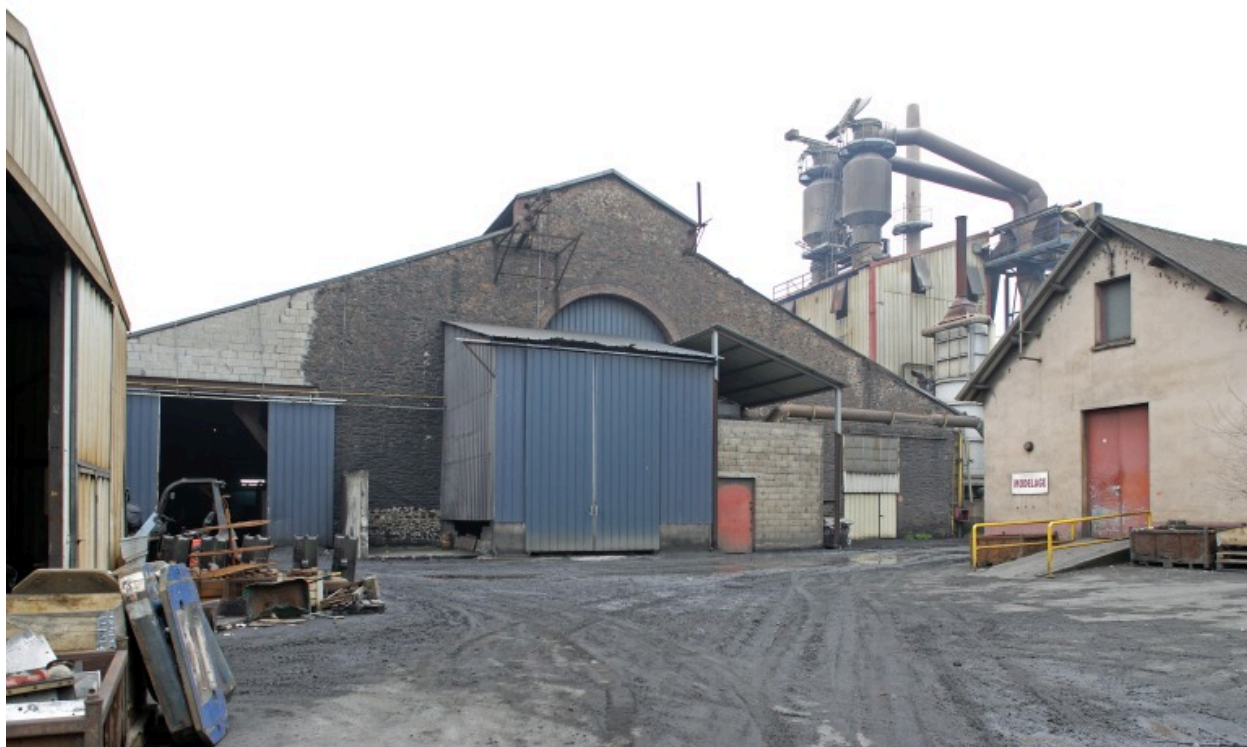
L'élévation nord de la halle de fonderie.
