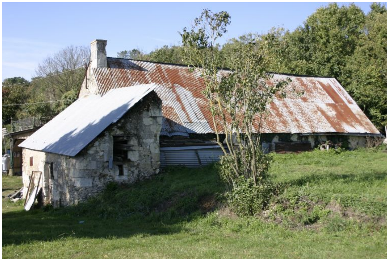
Maison 1 : façade postérieure à demi enterrée.
