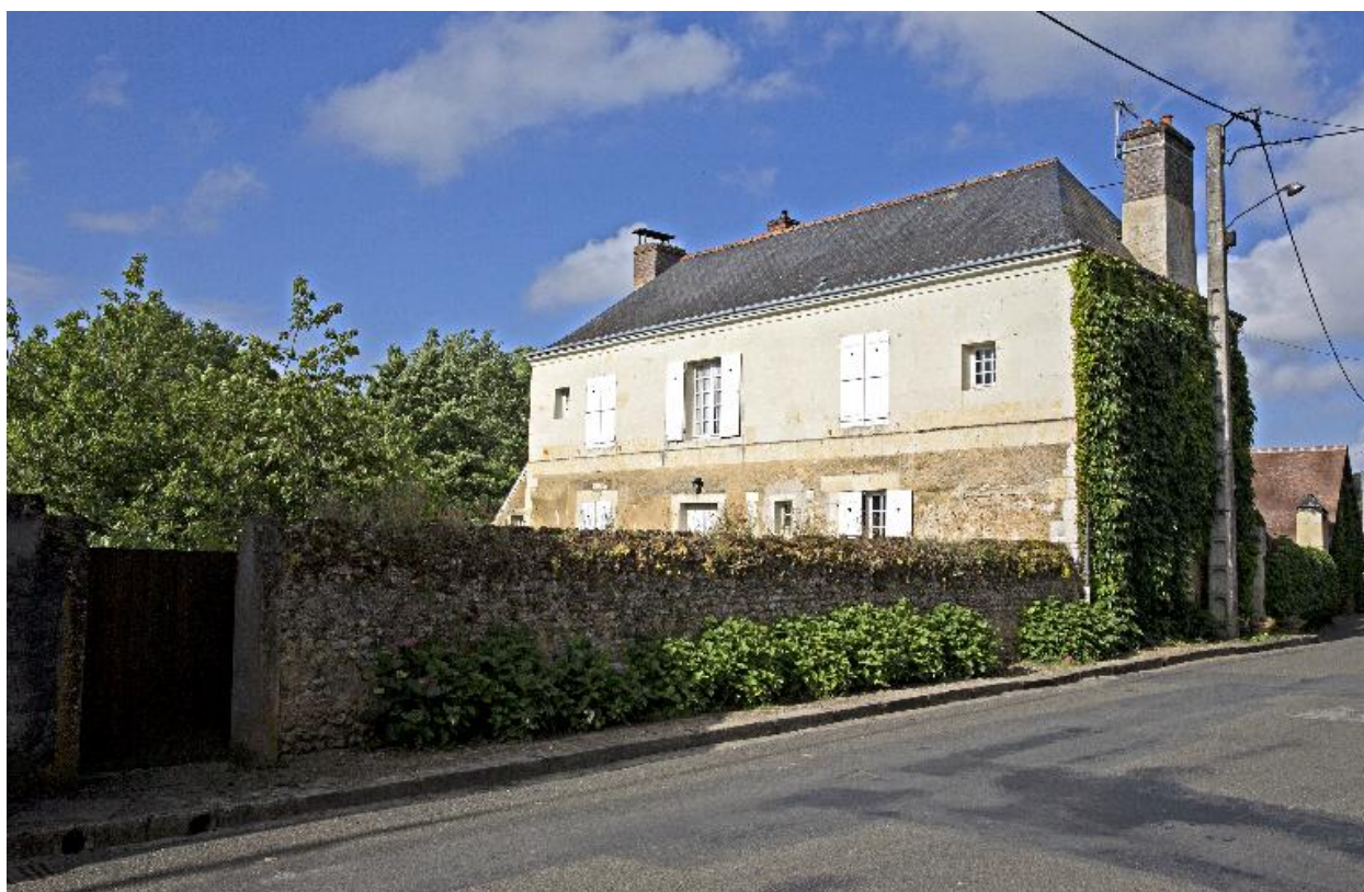
Vue d'ensemble depuis la rue.
