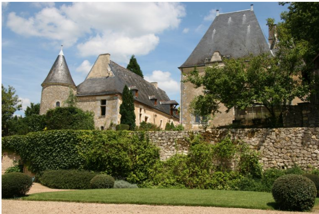
Vue d'ensemble de la plate forme.
