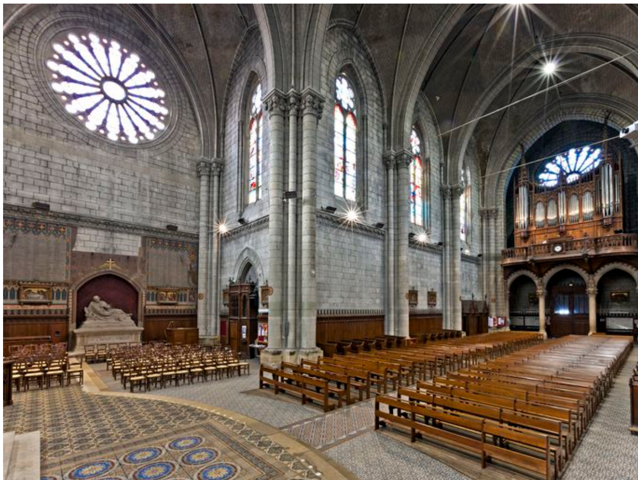
Vue vers l'ouest. Bras sud du transept et mur sud de la nef.
