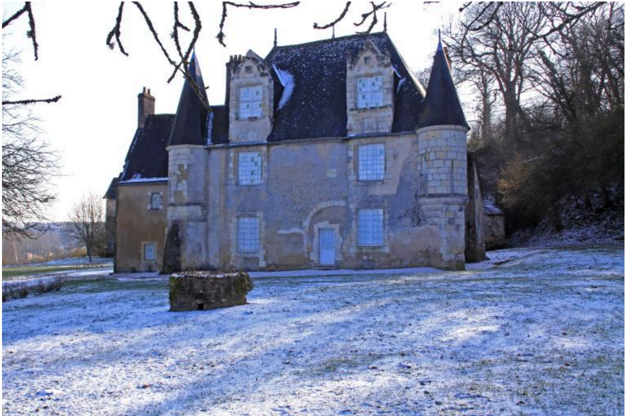
Façade sur avant-cour (ouest).
