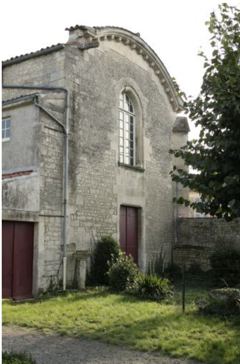
Façade nord de la chapelle.
