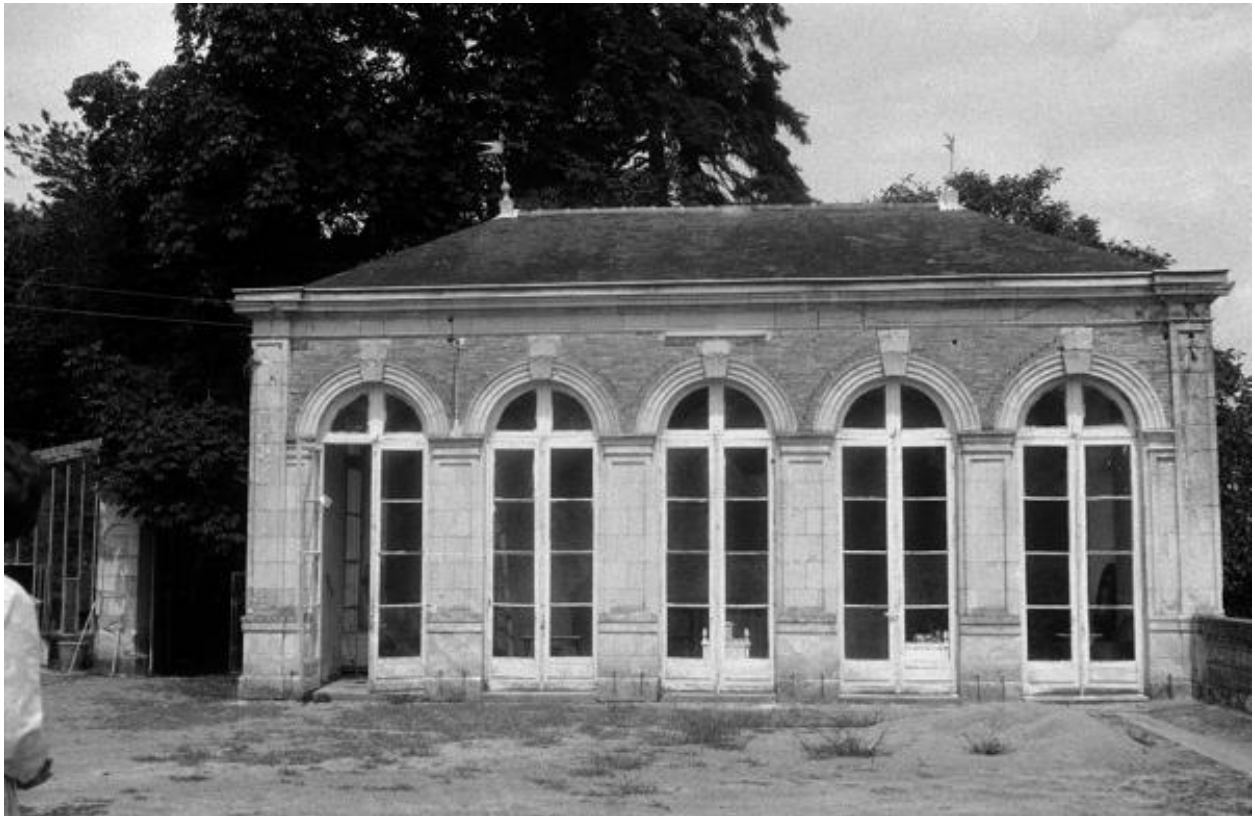
Château de Vaugirault. Vue de l'orangerie prise lors du pré-inventaire en 1972.
