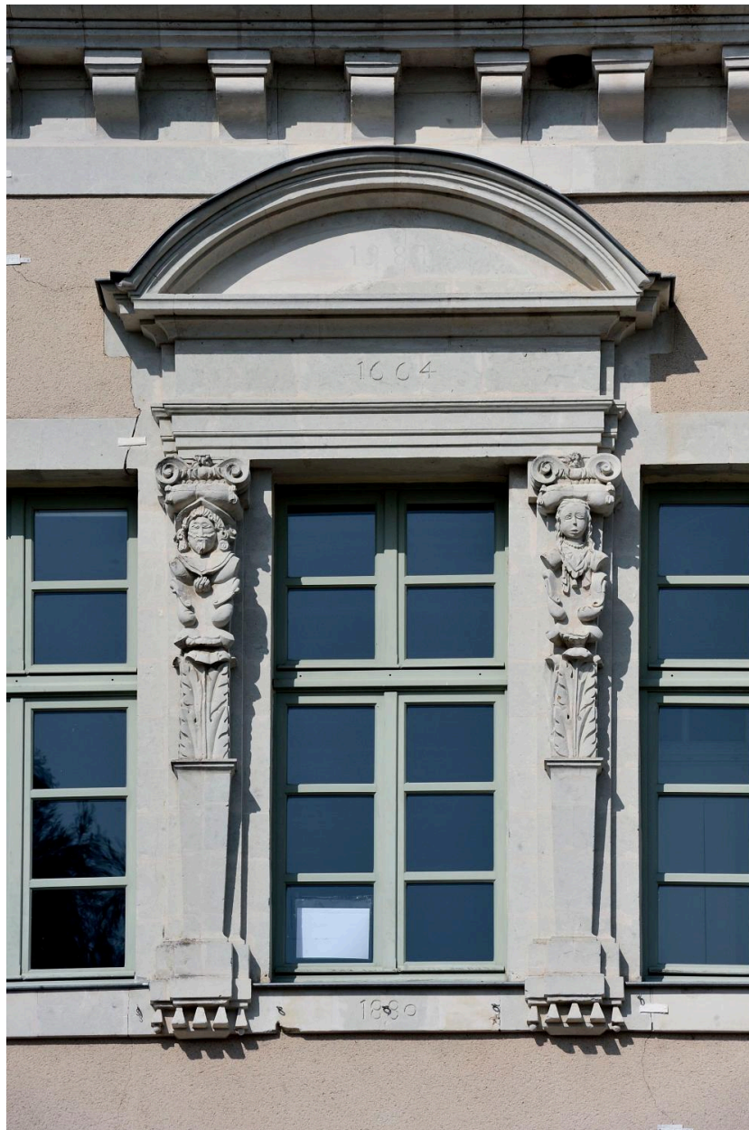
Logis dit de l'Abbaye à Bouchemaine. Détail de la fenêtre centrale de l'étage.
