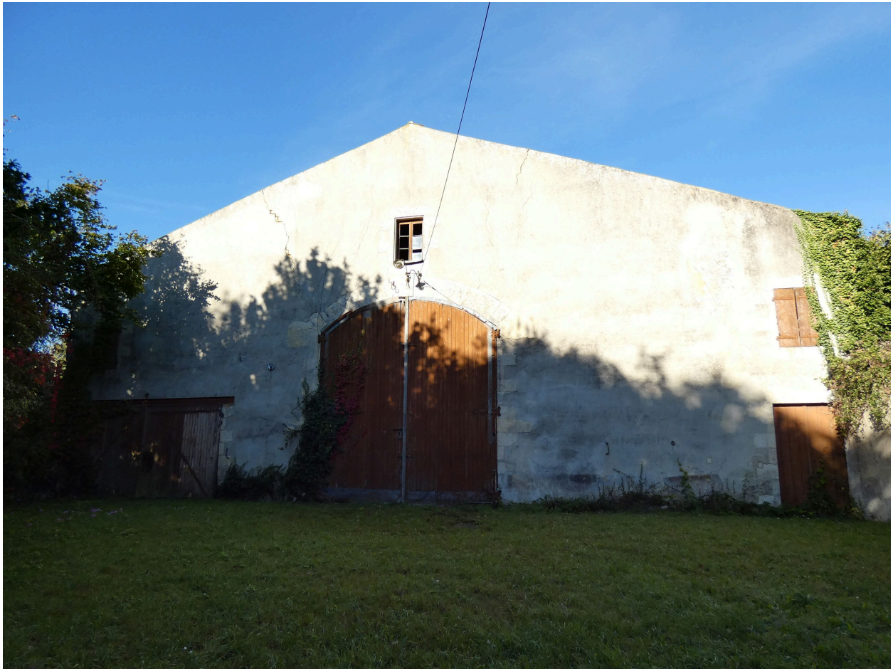
La grange-étable vue depuis l'est.
