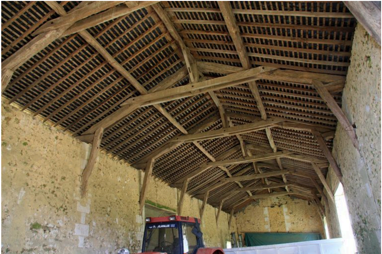
La grange : charpente boulonnée.
