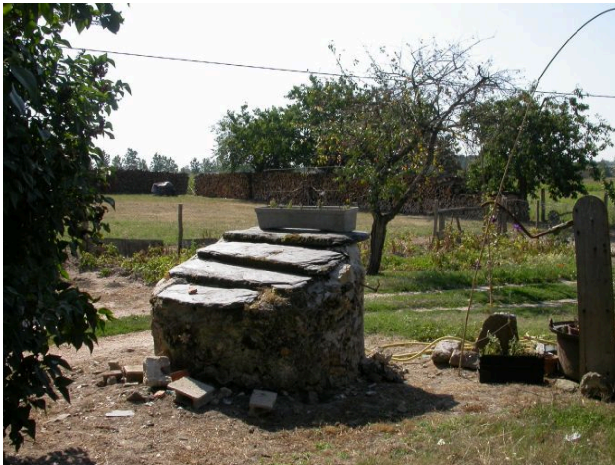
Le puits couvert de trois dalles de schiste.
