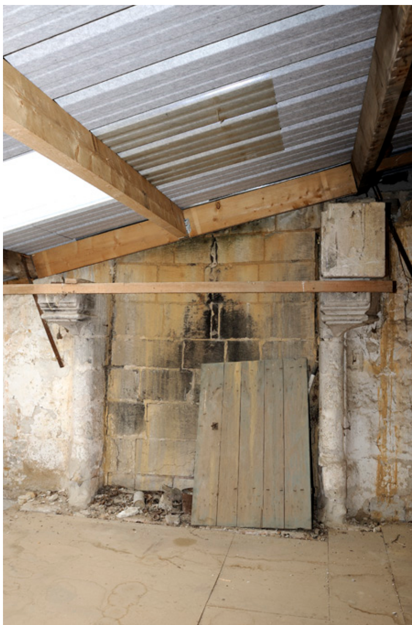
Etage, salle ouest : cheminée (seconde moitié XVe ou début XVIe siècle).
