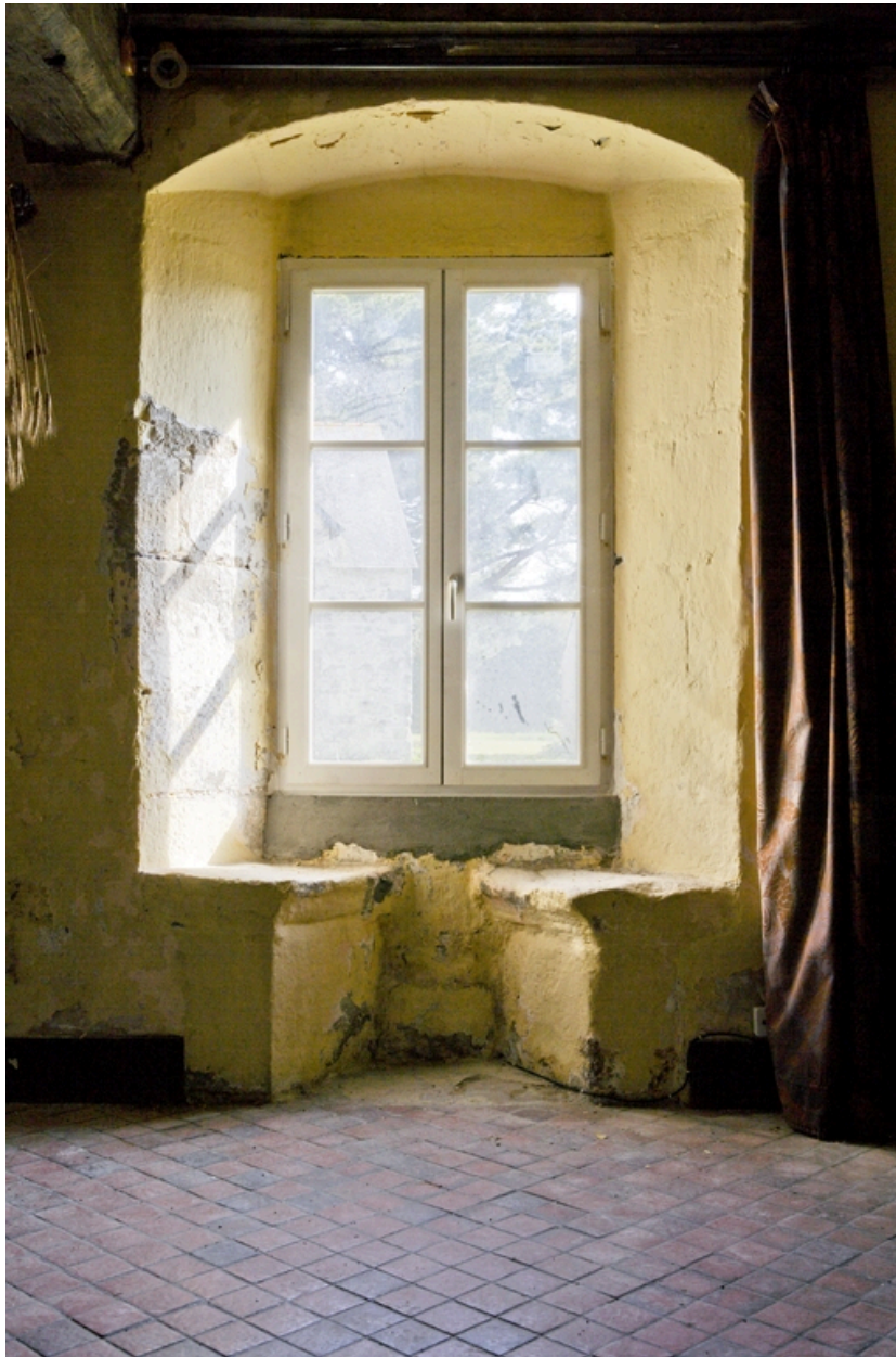
Aile ouest. Salle basse. Détail de la fenêtre à coussièges.
