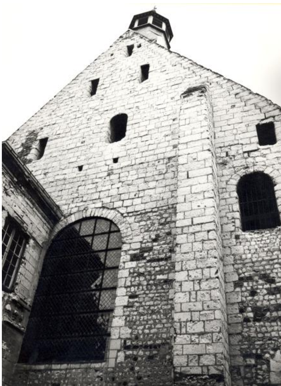
Eglise, pignon occidental, partie haute.
