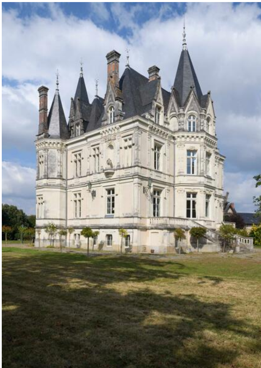
Vue des façades sud et ouest du château de la Barre.
