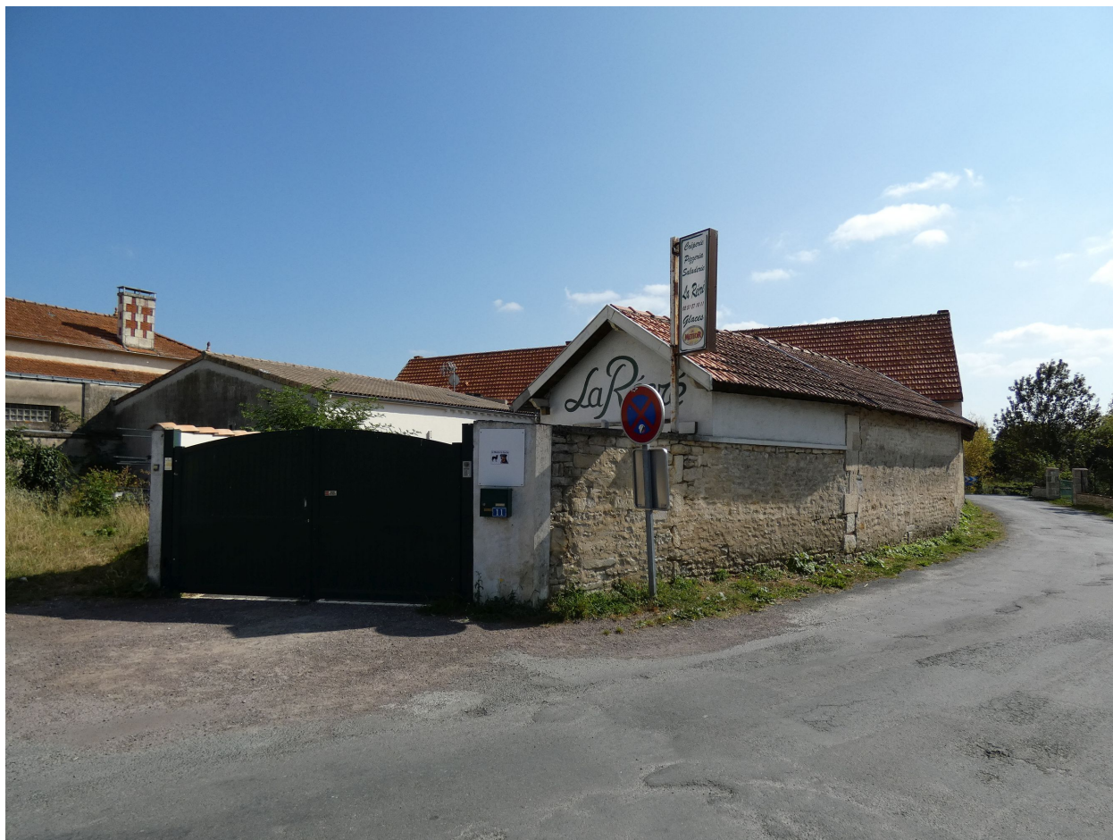
L'ancienne école vue depuis le nord-ouest.
