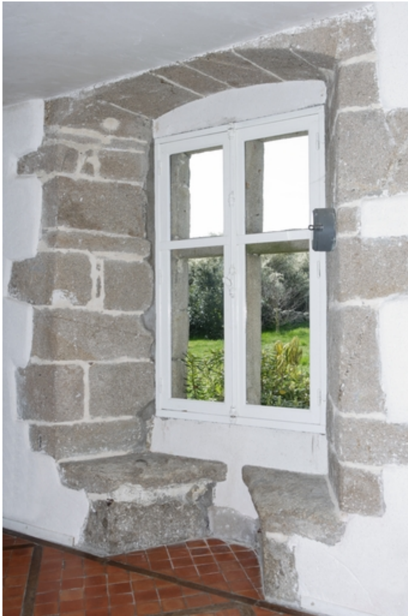
Rez-de-chaussée. Salle basse. Détail de l'embrasure de la croisée sud.
