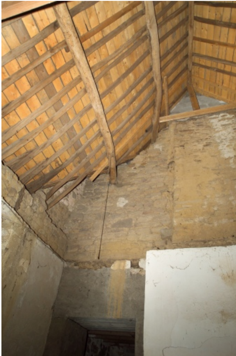
Bâtiment sud, charpente.
