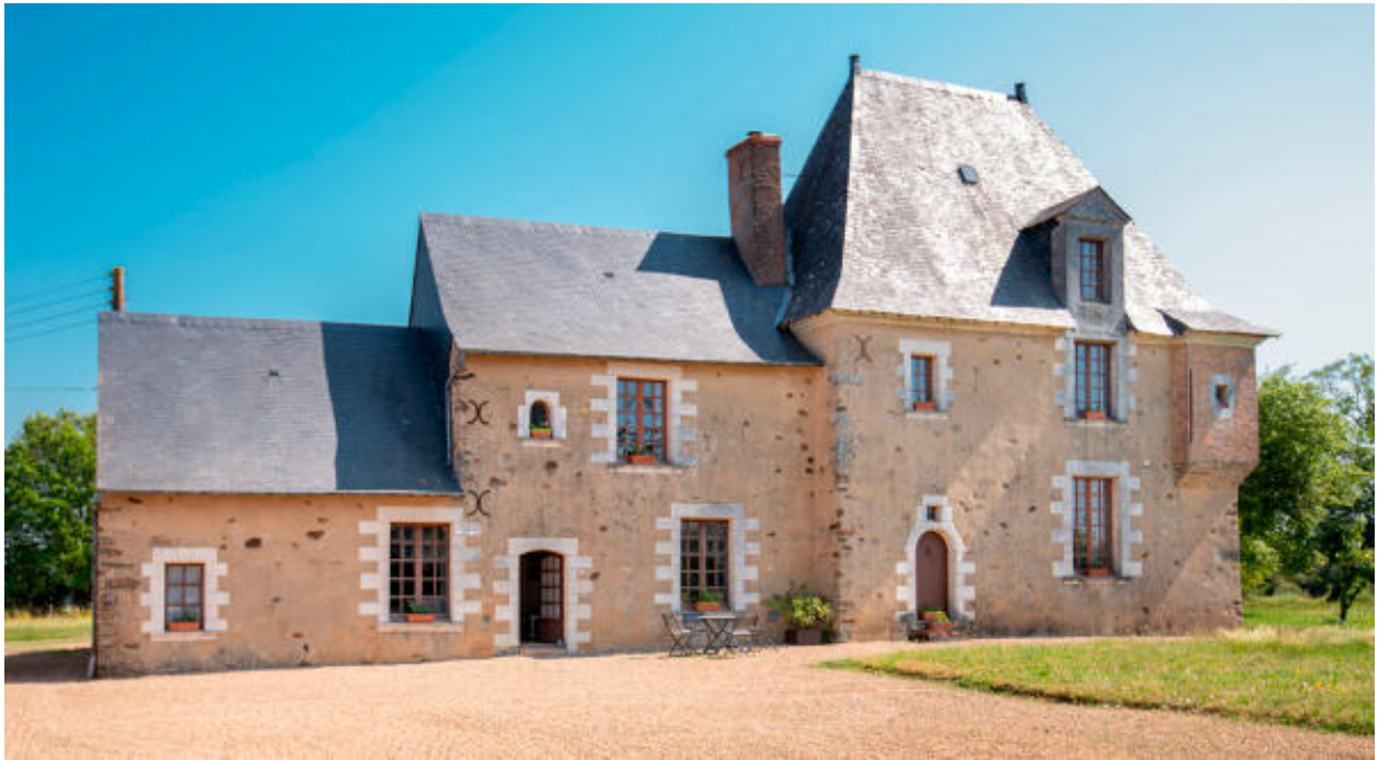
Le corps de logis, élévation principale.
