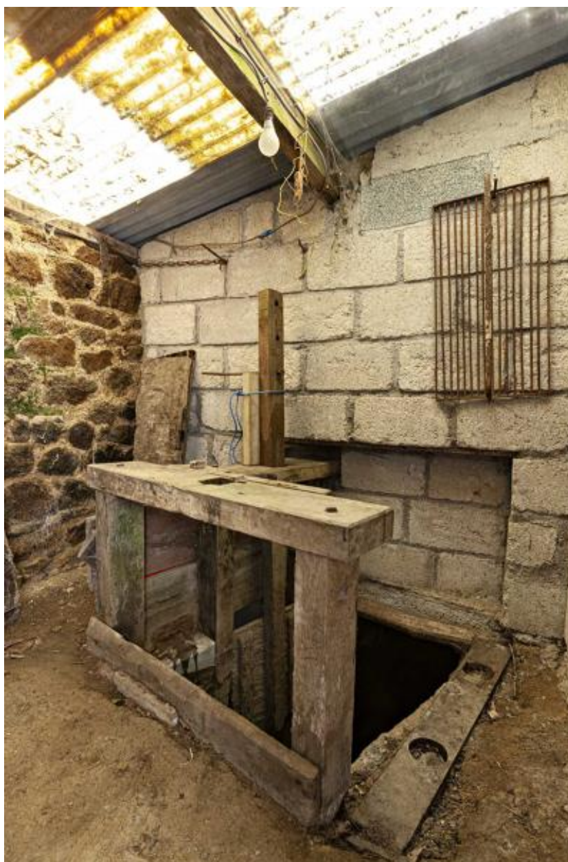
Mécanisme de contrôle des vannes.
