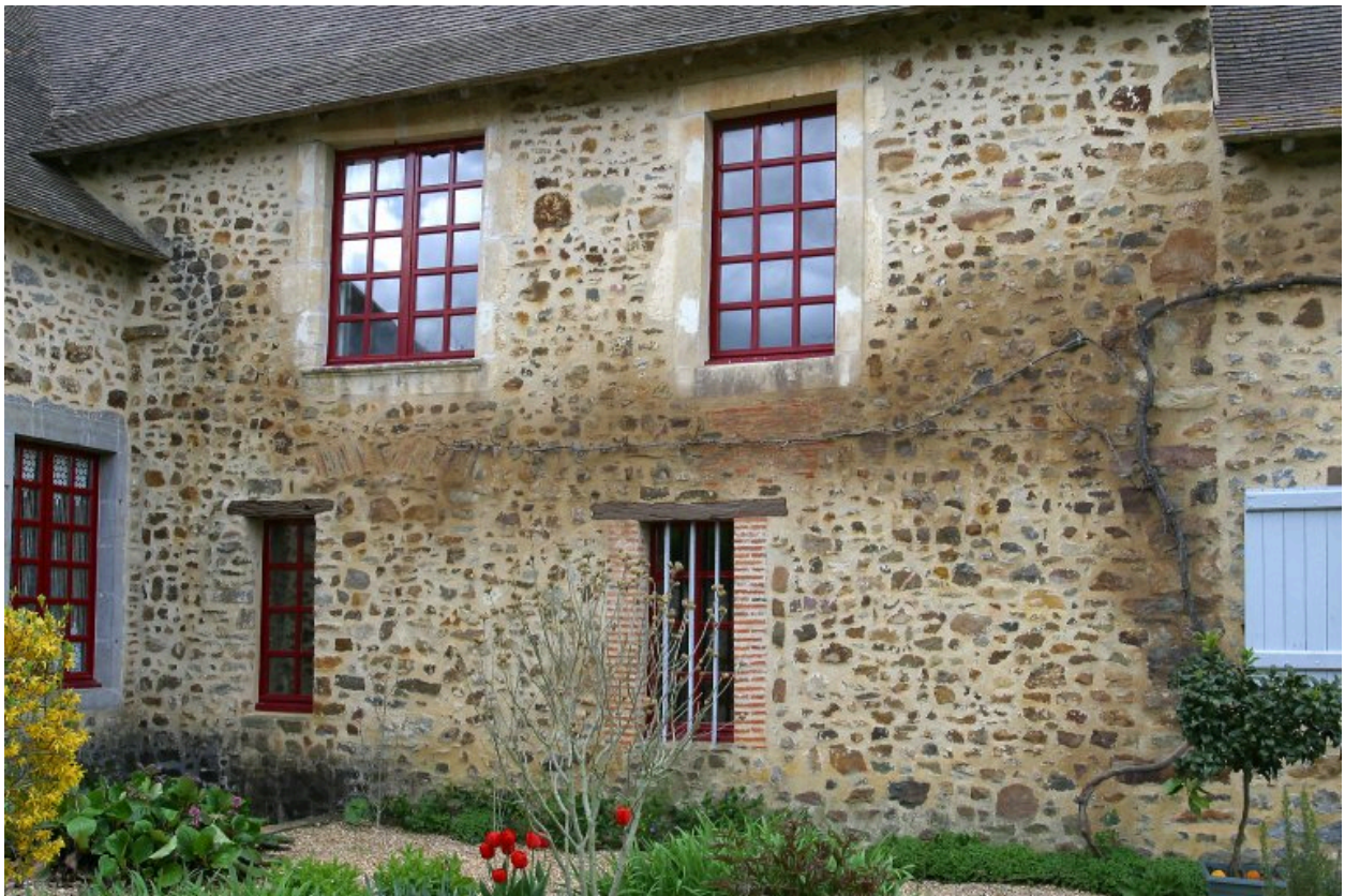
La façade principale du corps de bâtiment nord-est.
