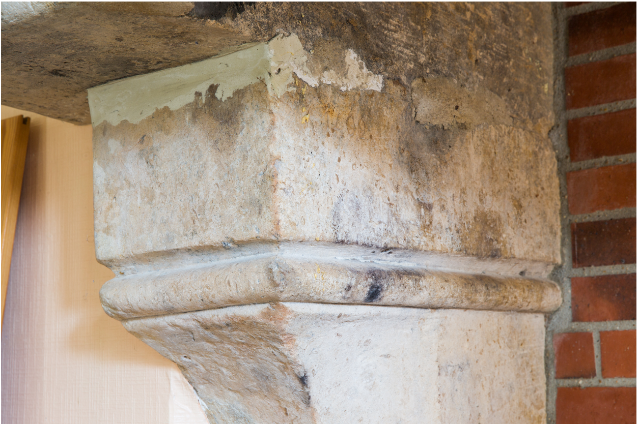
Un détail d'une cheminée.
