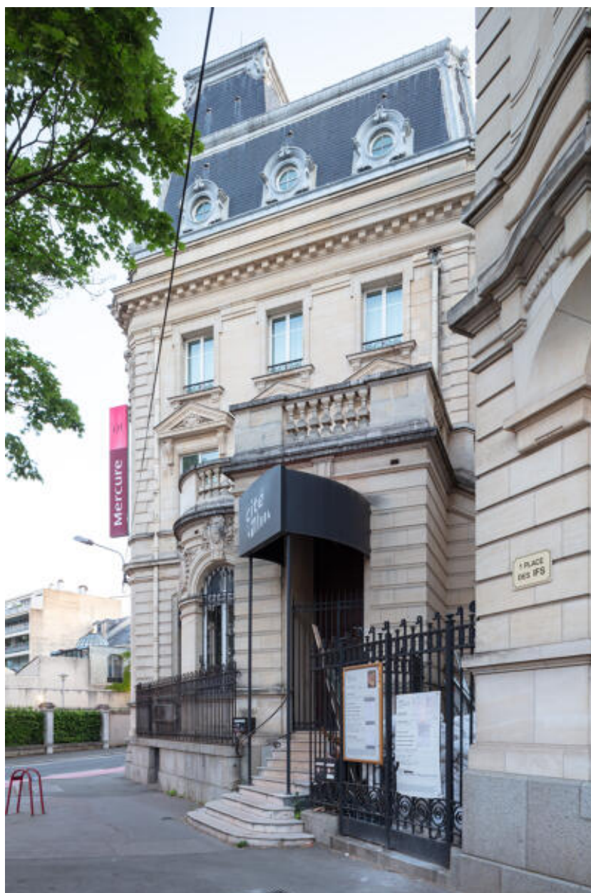
Vue de la façade latérale sud du bâtiment de bureau des mutuelles.
