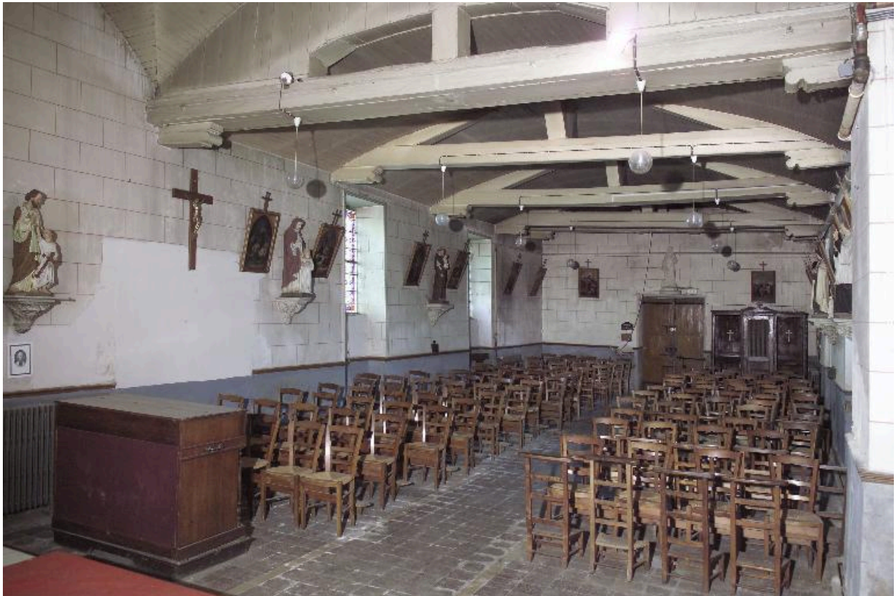
La chapelle : la nef depuis le chœur.
