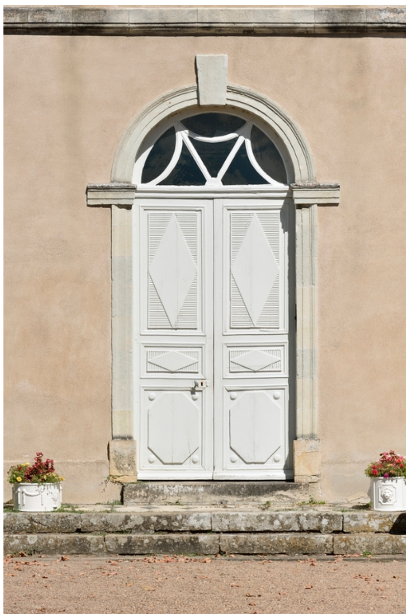
Façade sud. Détail de la porte d'entrée.
