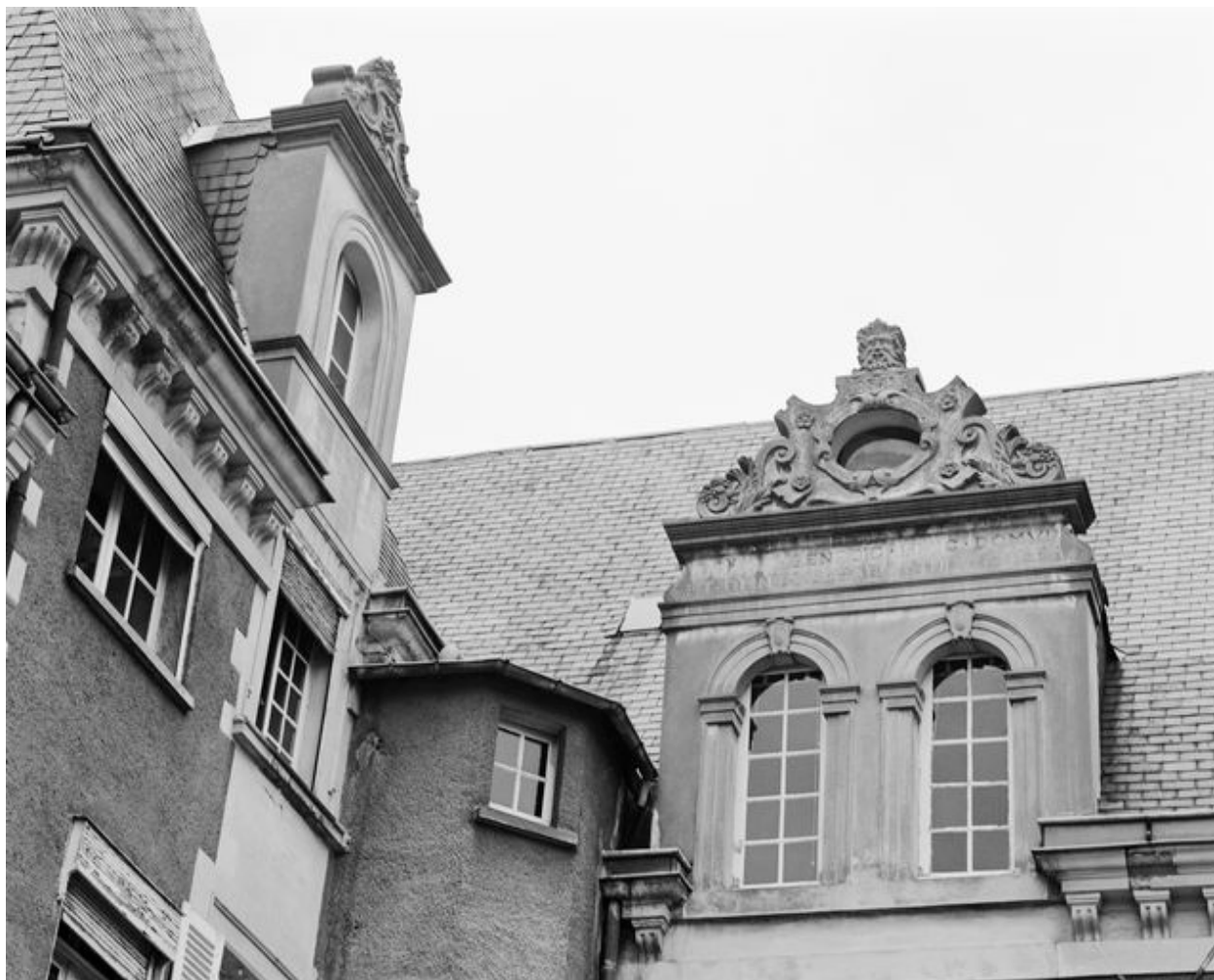
Bâtiments conventuels. Partie située au n° 2, dite logis de Goddes. Elévation sud, lucarne ouest.
