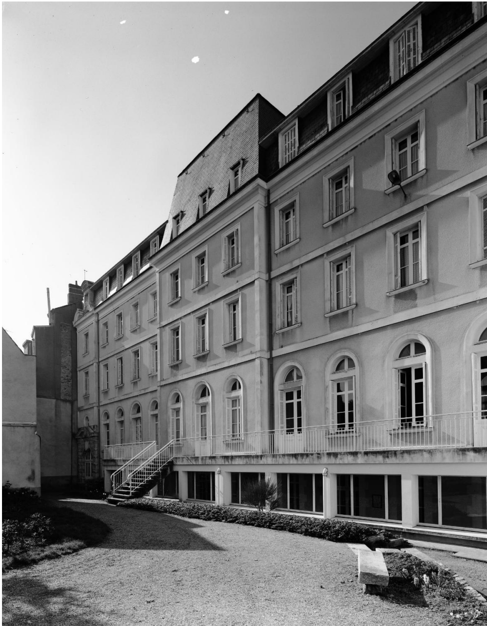
Grand corps de bâtiment élevé sur la rue David-d'Angers : élévation sur jardin.
