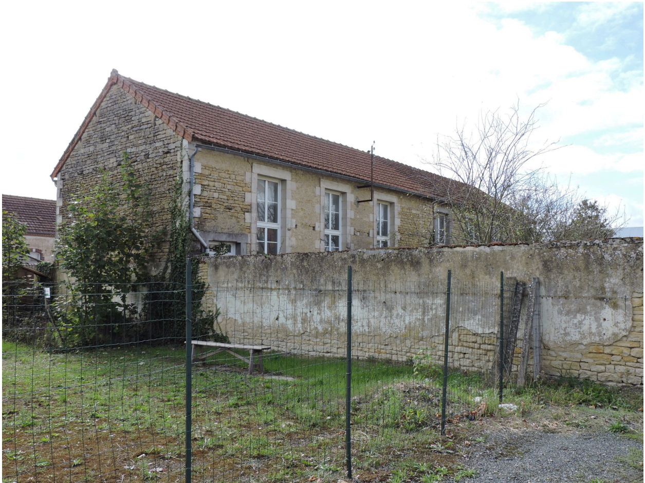
Le bâtiment de classes nord, vu depuis le nord-est.
