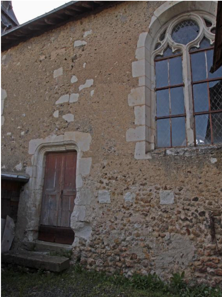
Façade sud de la nef.
