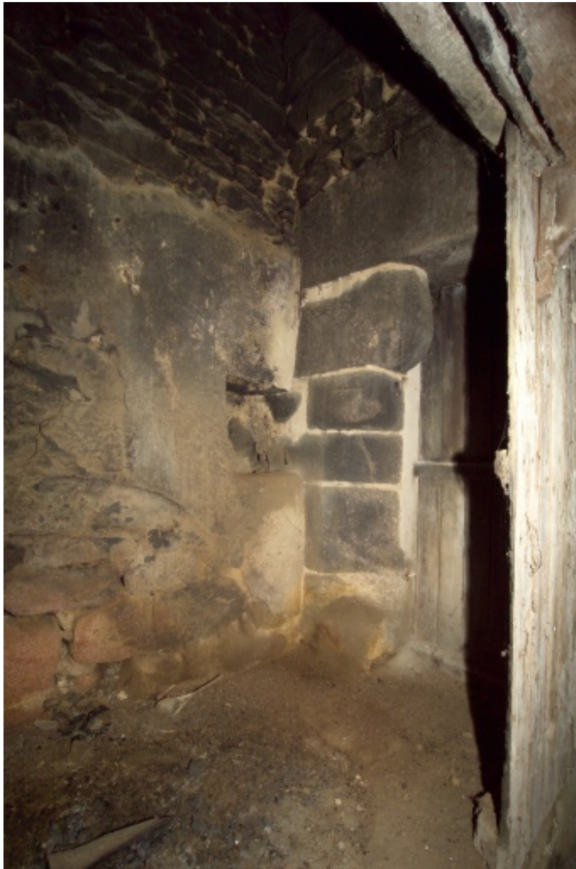
Bâtiment sud, détail cheminée.
