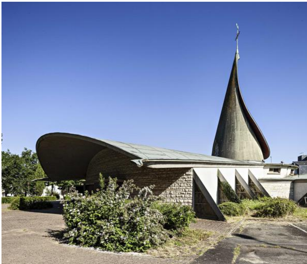
Vue de la façade latérale de l'église.
