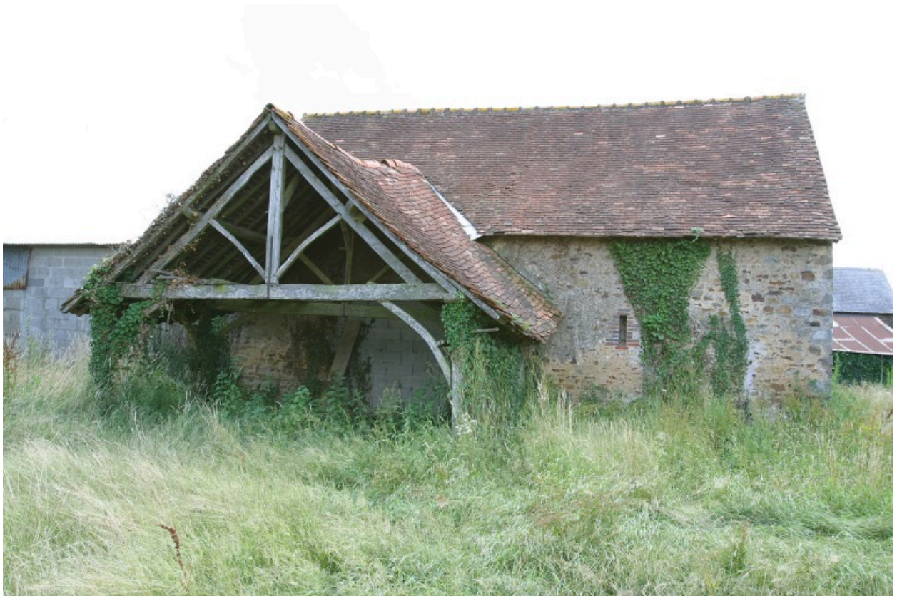
La remise vue du nord.
