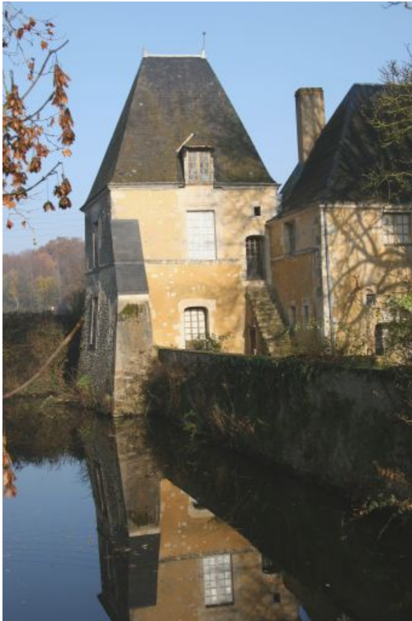
Pavillon nord-ouest de la plateforme à l'extrémité des communs.
