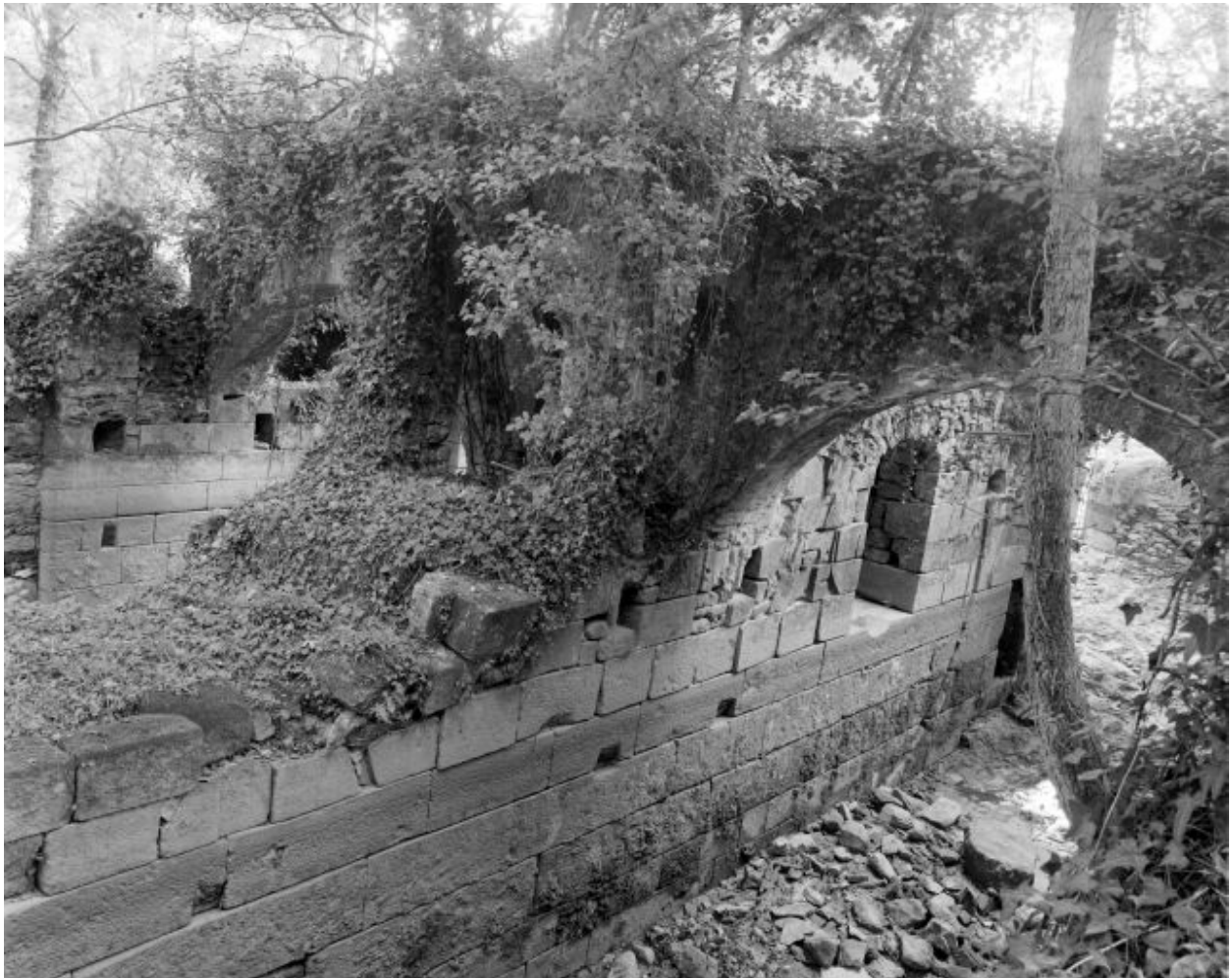
Le coursier latéral sud vu du sud-ouest : mur bajoyer nord, arc. A gauche, le mur bajoyer nord du coursier latéral nord.
