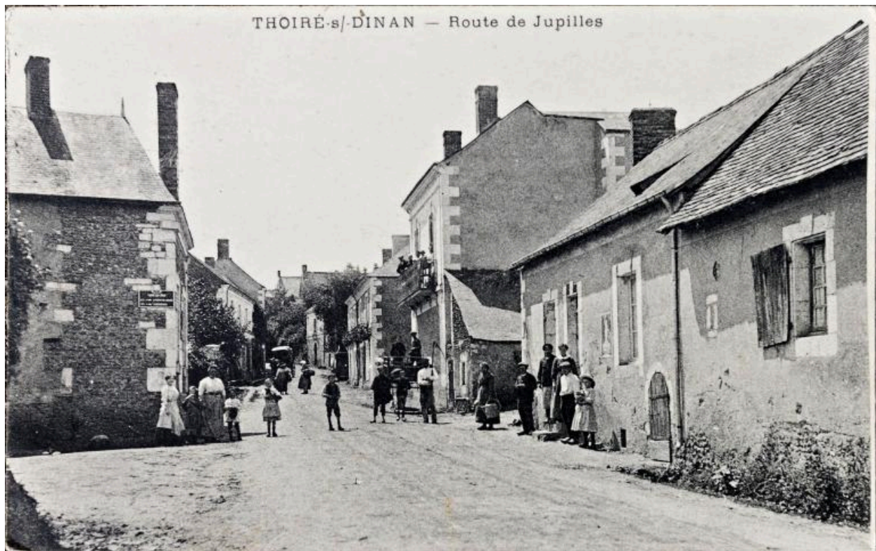
Route de Jupilles (rue du Dinan). A droite, une partie de l'écart de l'Hêtre Podenier.
