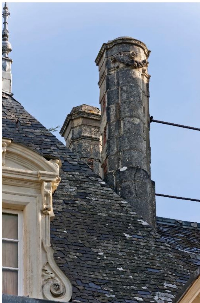
La souche de cheminée droite du corps principal.
