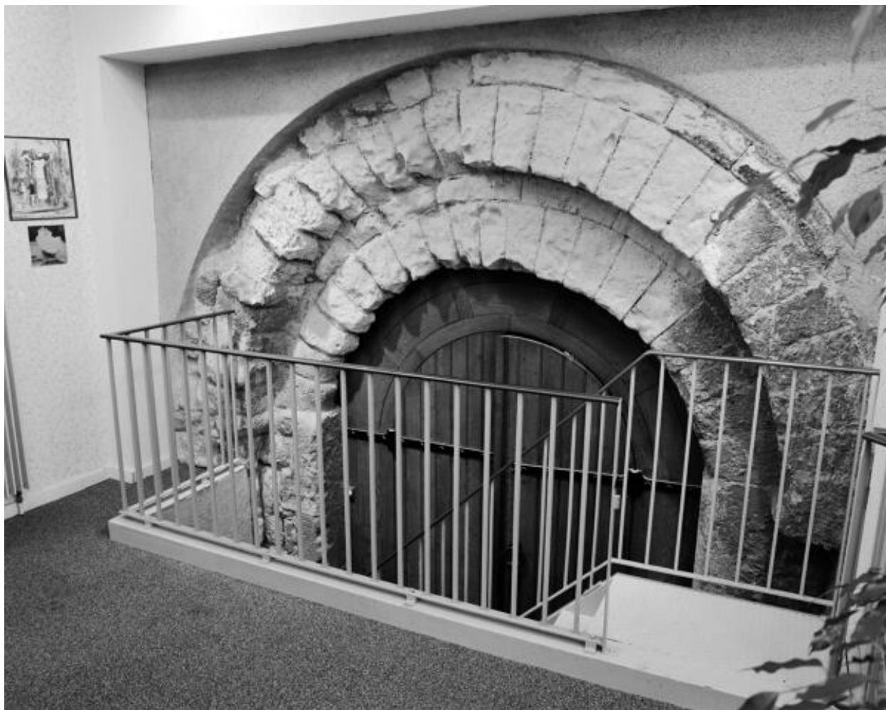
Aile occidentale de l'abbaye, mur ouest (sur la cour de service), extrémité sud : porte des celliers, élévation extérieure.
