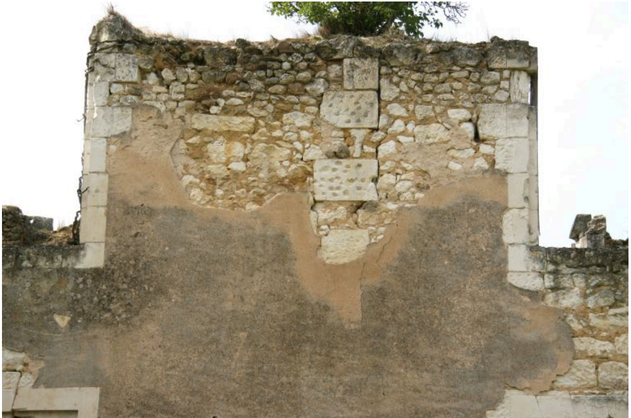
Le logis, façade sur jardin : collage dans la maçonnerie.
