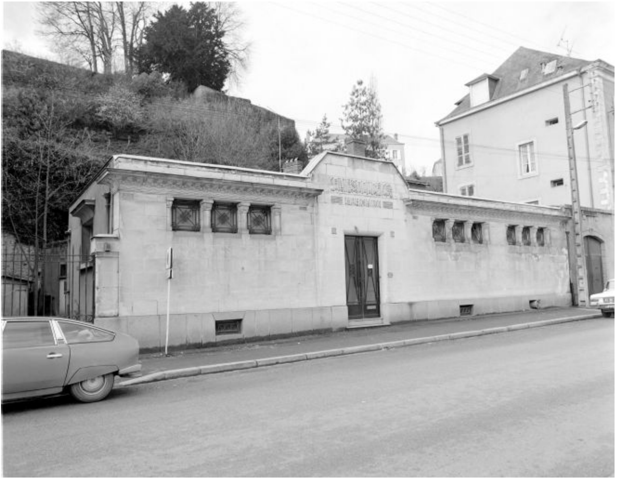
Façade antérieure sur rue : vue d'ensemble.
