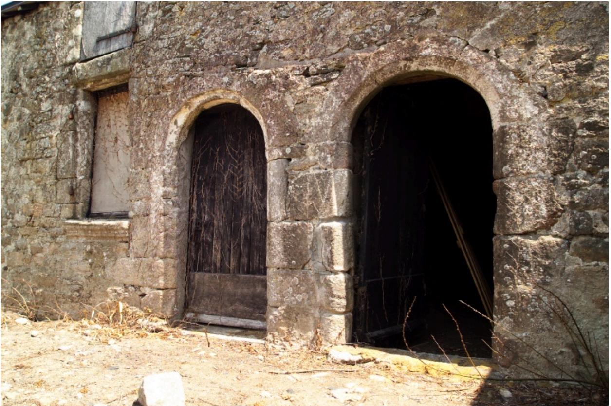
Bâtiment nord, détail portes.
