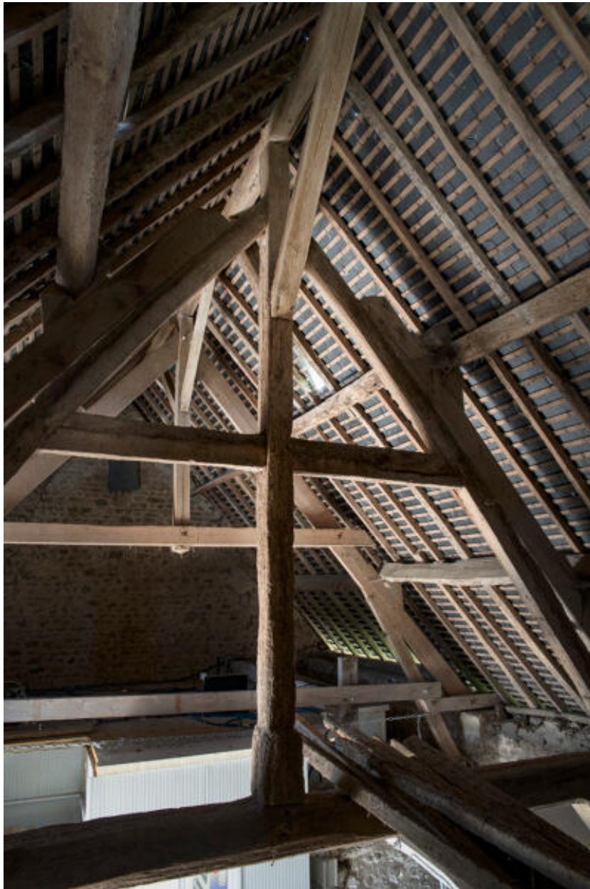
Charpente de la grange, ferme centrale.
