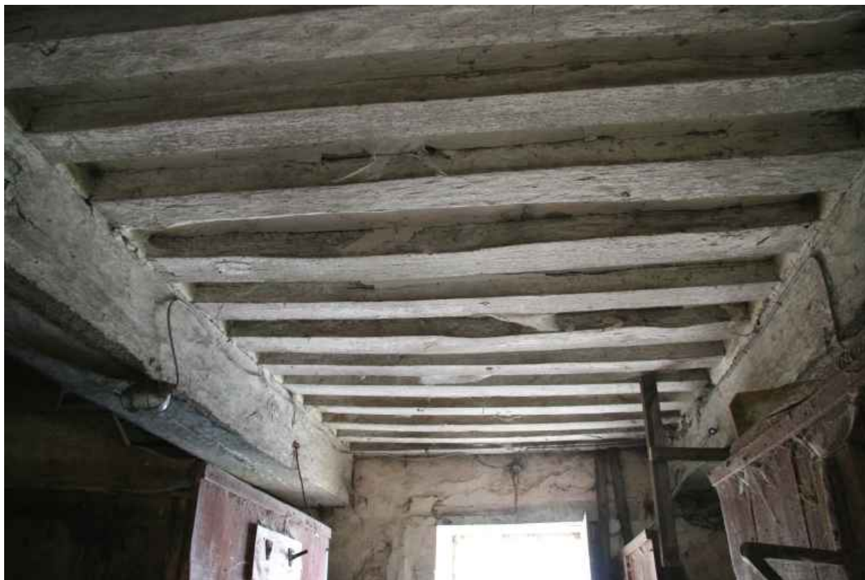
Aile ancienne : plafond du rez-de-chaussée.
