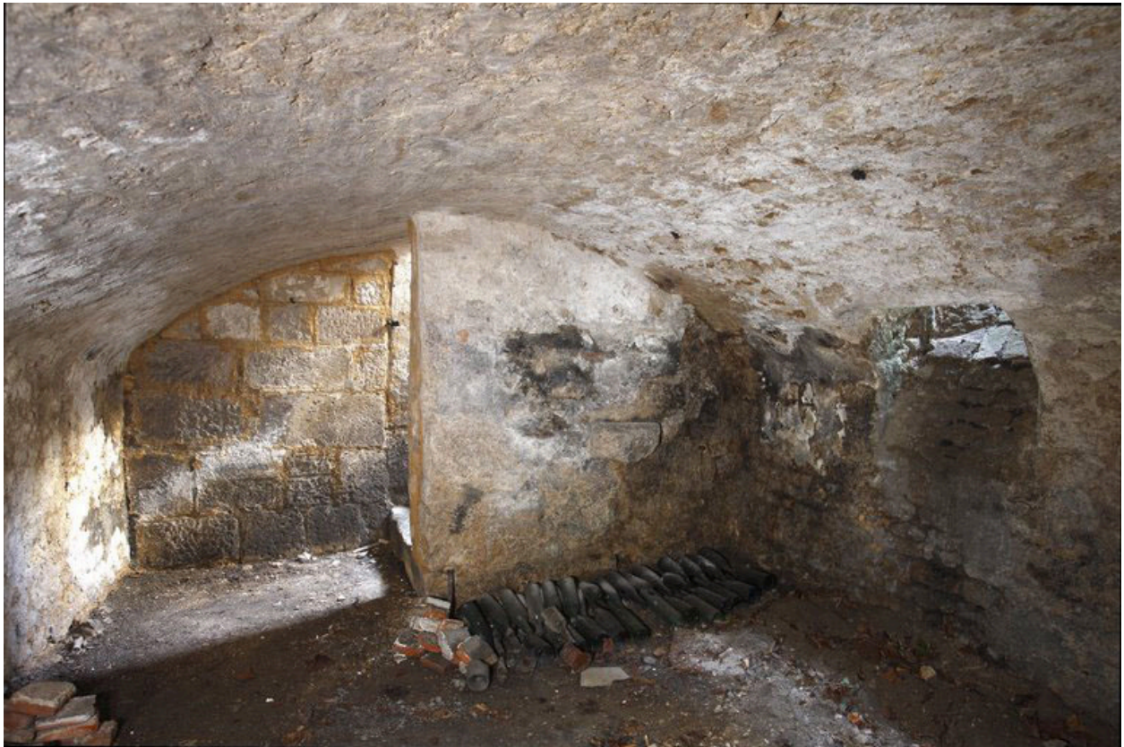
Vue du sous-sol.
