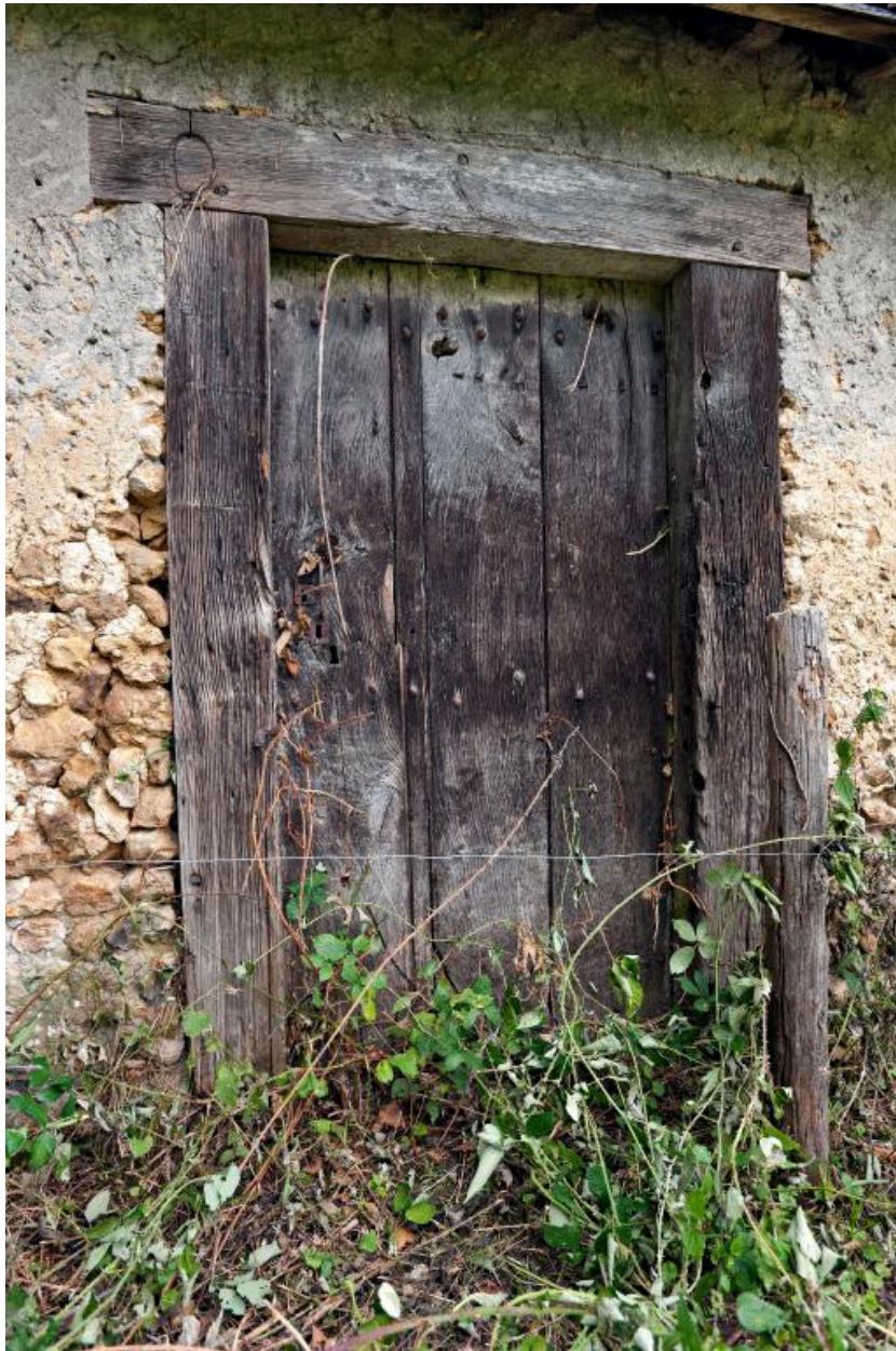
Façade antérieure : porte d'entrée sur la chambre à feu, encadrée de bois.
