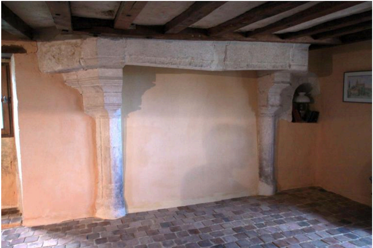
Logis, étage : cheminée de la salle nord-ouest.
