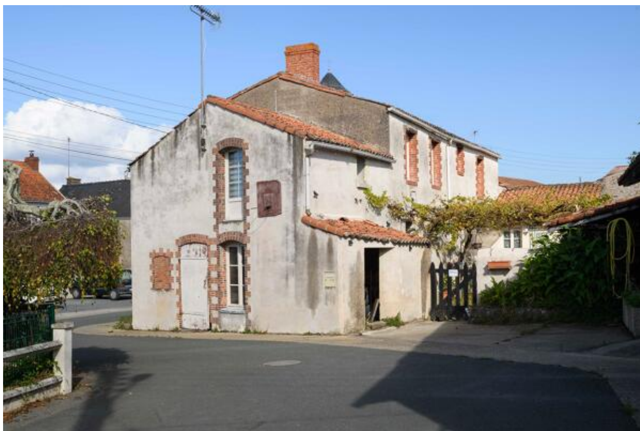
Maison, 3 rue de l'Airault.
